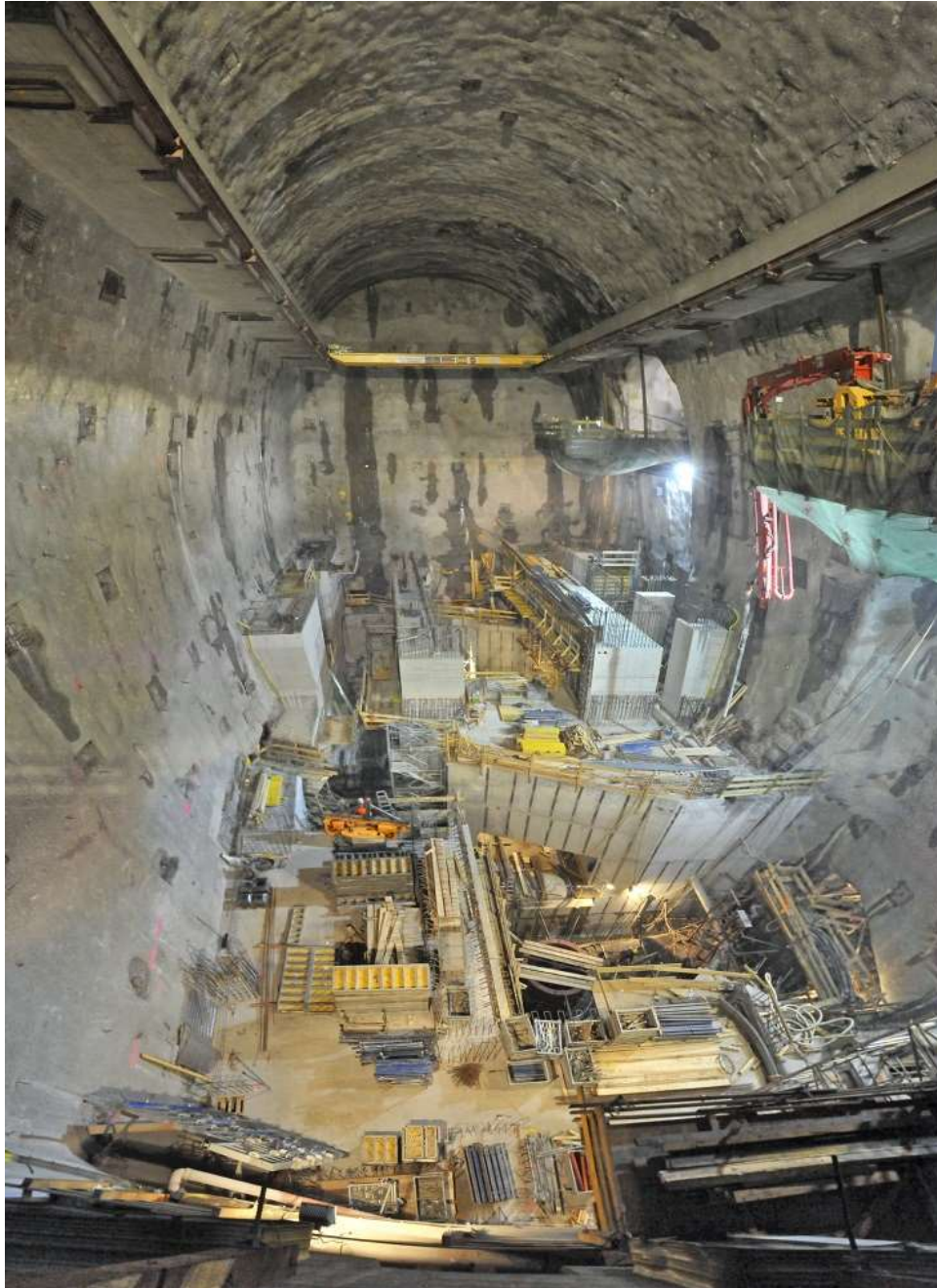
Рисунок 39 – Підземний машзал ГАЕС перед закінченням будівництва. (стіни закріплено попередньо-напруженими анкерами та омоноліченим набризк-бетоном)
