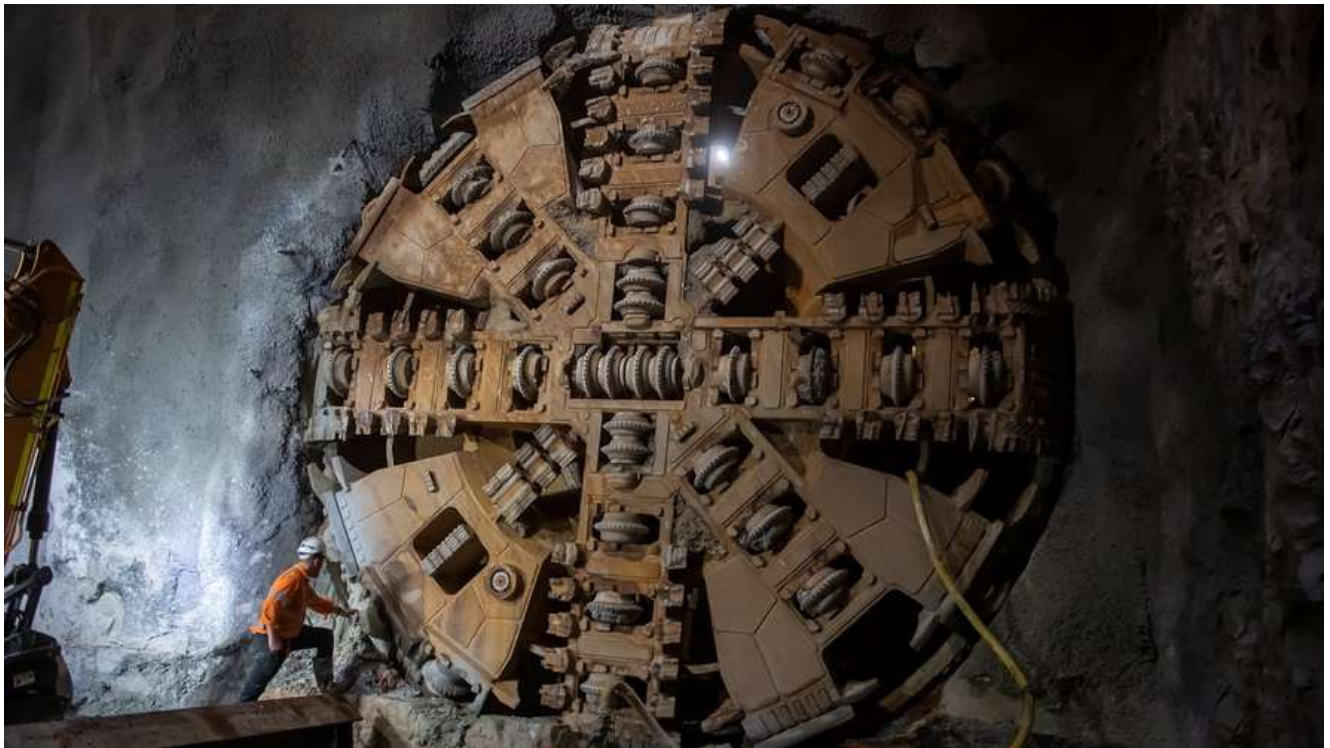
Рисунок 16 – Загальний вигляд тунелепрохідницької машини
