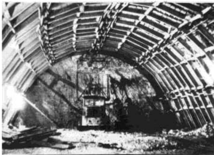
Рисунок 22 – Металеве арочне кріплення в дериваційному тунелі Інгурської ГЕС
